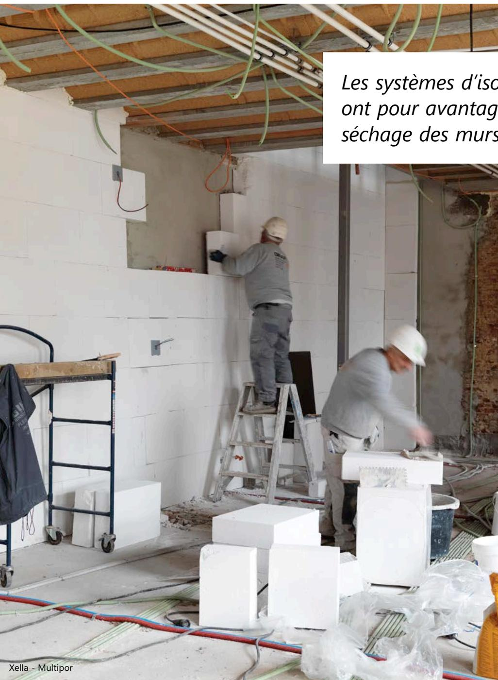
*Les systèmes d'isolation capillaires actifs ont pour avantage de permettre le séchage des murs humides vers l'intérieur.*
