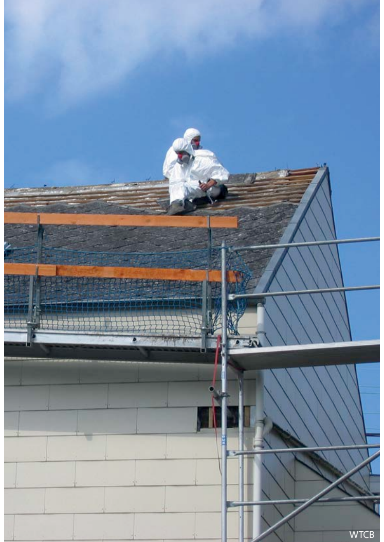
2 | Verwijdering van asbest op een dak met elementen uit asbestcement.
