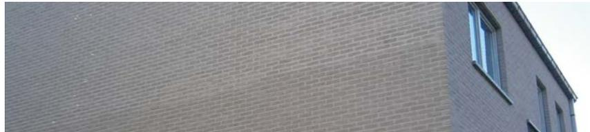
à signaler que la technique de jointoiment peut également avoir un impact. En effet, le risque d'obtenir des variations de teinte est plus important avec la technique de jointoiment dite 'en montant'.
