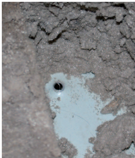
Afb. 3 Uitrukking van de schroef bij stormweer.
