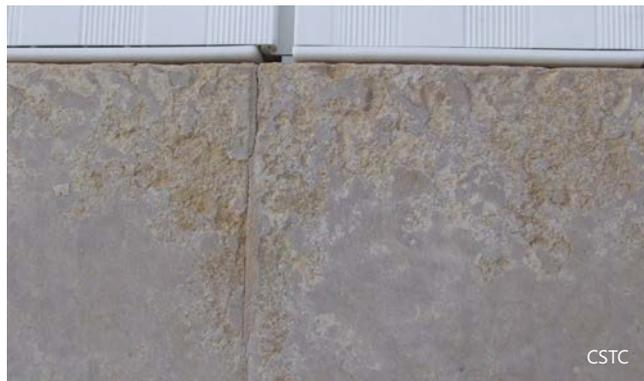
**1 et 2** | Exemples de pierres calcaires altérées par une eau trop douce, éventuellement en raison d'un dérèglement du traitement de l'eau.
