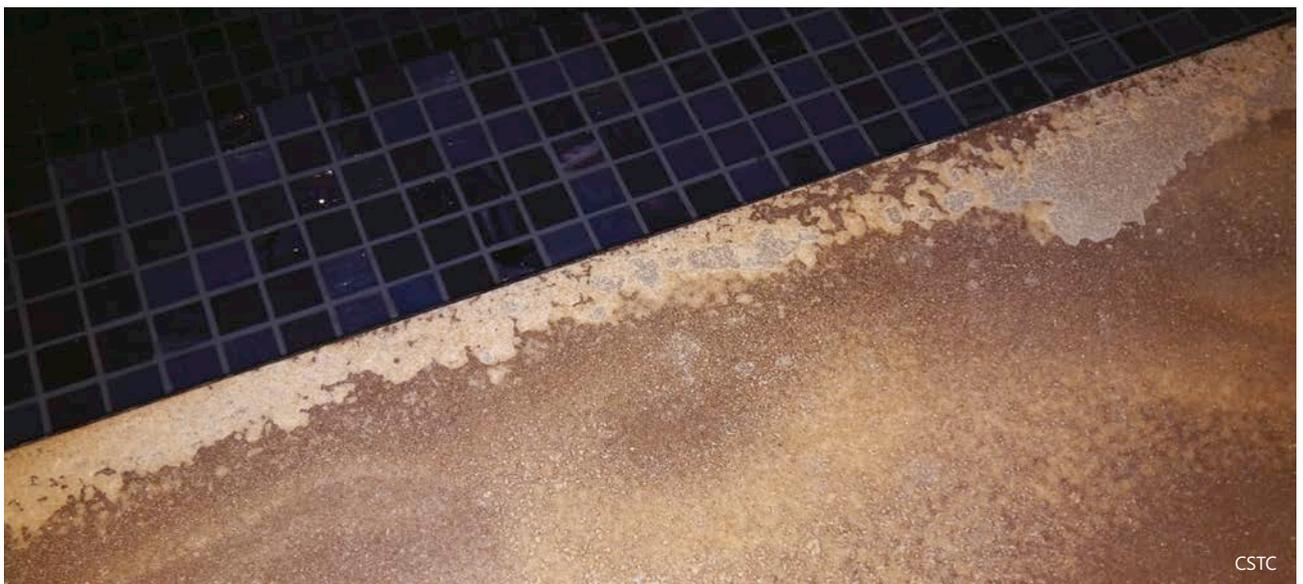
3 | Formation de gypse à la surface ou au sein de la pierre en fonction de sa porosité et/ou d'un éventuel traitement hydrofuge.
