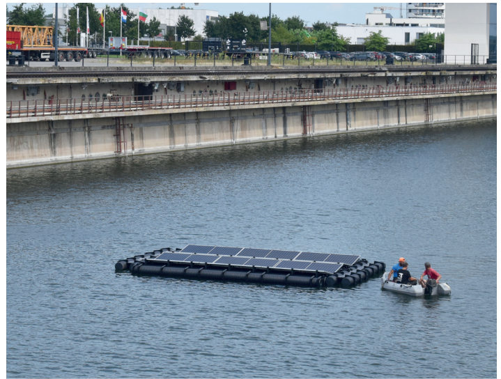
De Cordeel Groep is bezig met de installatie van zonnepanelen op het dok. Bedoeling is te onderzoeken of het koelende effect van water tot een hoger productierendement van de pv-panelen zal leiden.
