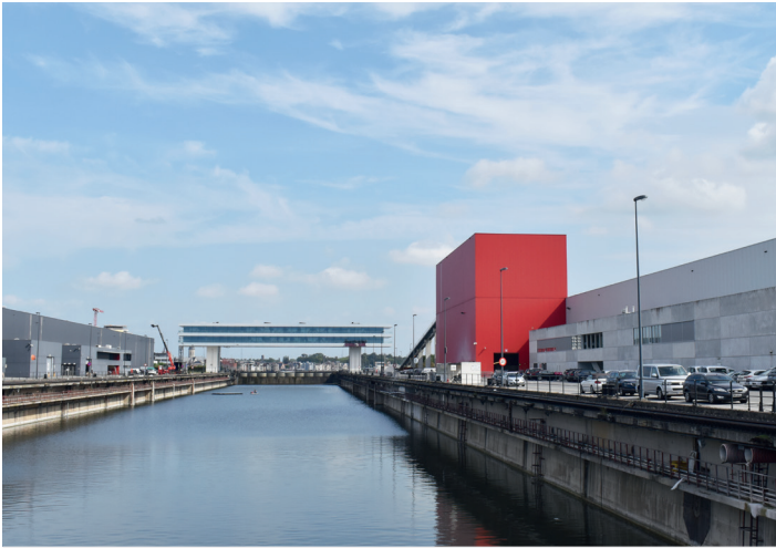
Het hoofdkantoor is als een toegangspoort over het dok gebouwd. De diverse productieafdelingen van de bouwgroep zijn rond het dok verzameld.
