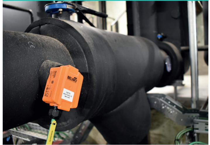
Alle installaties worden in detail bemeten. In dit geval gaat het om de monitoring van de retourtemperatuur van het BEO-veld.
