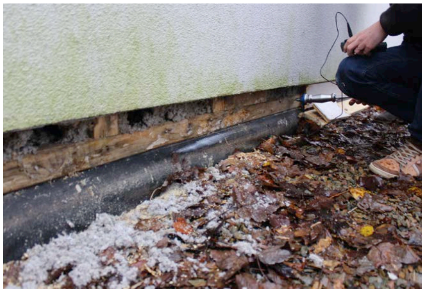
1 | Analyse van de beschadigingen aan de muurvoet.
