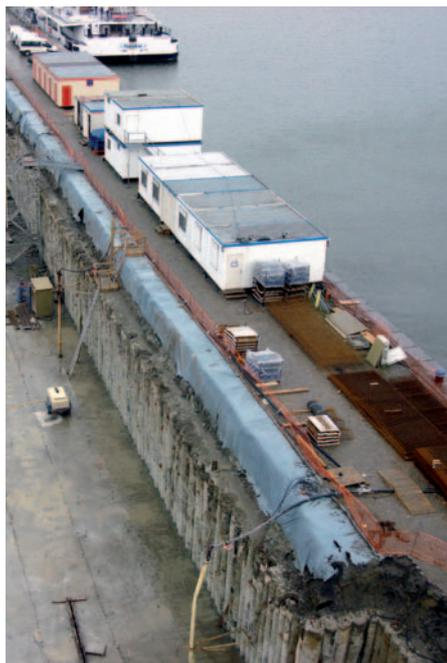
**Fig. 1** Mur de soutènement en sol traité.
