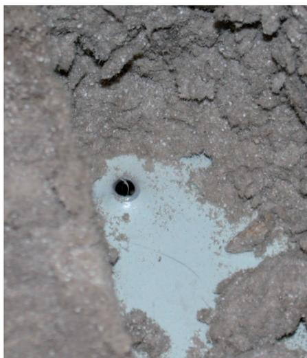
**Fig. 3 Arrachement de la vis en cas de tempête.**
