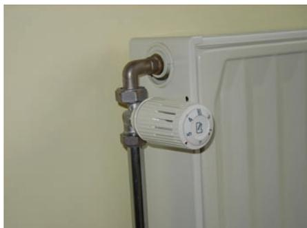
**La vanne thermostatique : une solution simple pour réguler la température intérieure de chaque local.**
