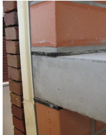
**Détail de construction innovateur avec joint souple (isolation acoustique améliorée).**
