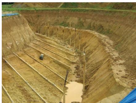
Tests de tirants d'ancrage à échelle réelle.
