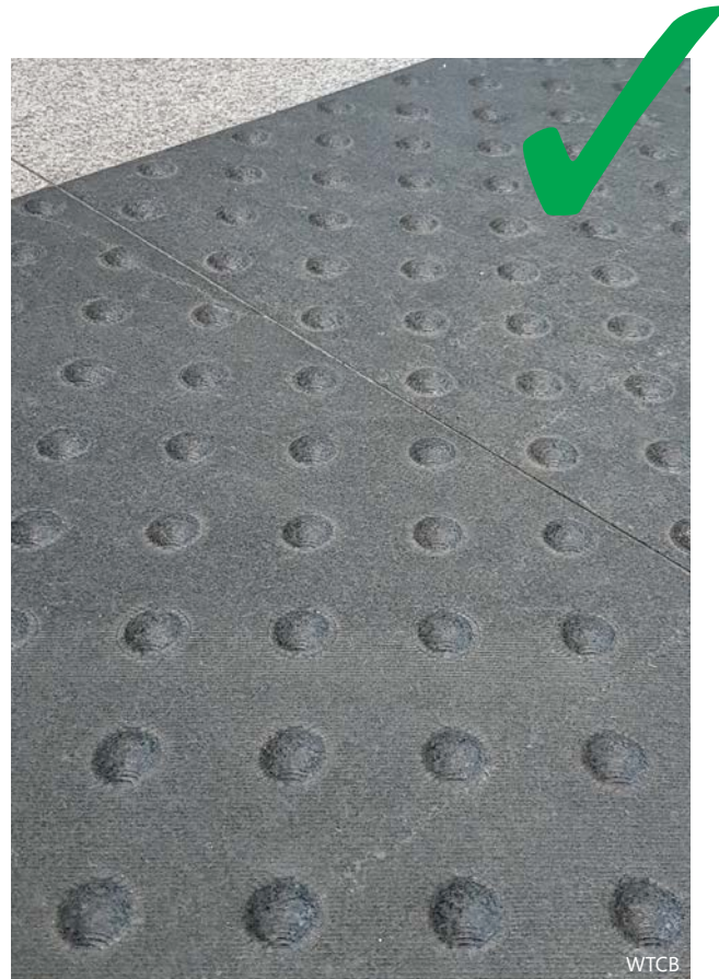
2 | De noppen van aangrenzende tegels moeten perfect op één lijn liggen en dezelfde afmetingen hebben.
