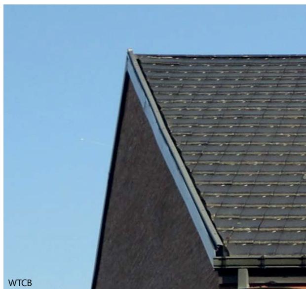
2 | Afwerking van de dakranden met een specifiek profiel.
