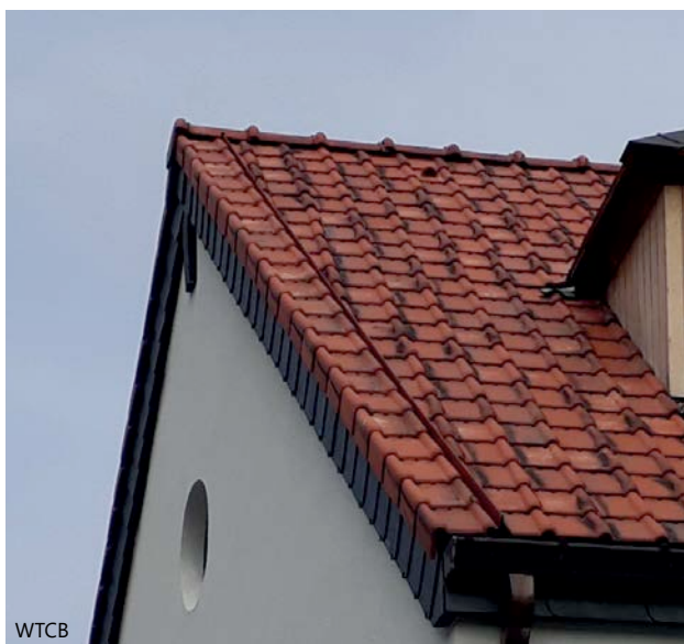
1 | Afwerking van de dakranden met gevelpannen.
