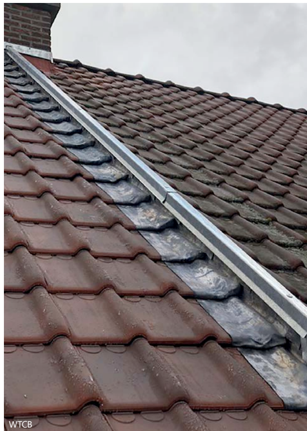
3 | Aansluiting tussen een gerenoveerd dak (links) en een bestaand dak (rechts) met behulp van een roeflat.
