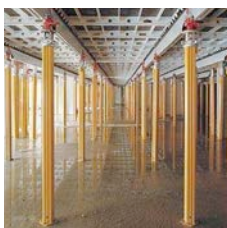
Doorstempelen van vloerplaten
