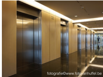
Afb. 1 Bij brand zelfsluitende brandwerende deuren.
