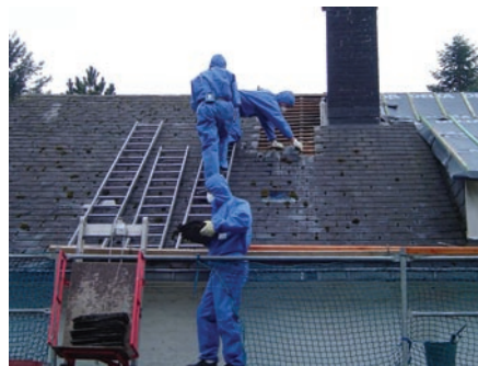
Ontmanteling van elementen uit asbestcement in buitenomstandigheden.
