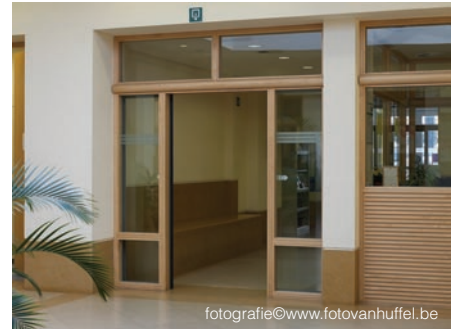
Afb. 2 Brandwerende deur met beglaasde boven- en zijpanelen.
