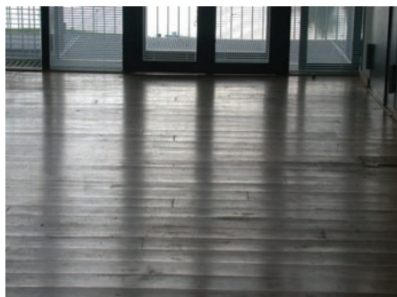
Afb. 3 Slechte keuze van de plaatsingsrichting van de elementen.
