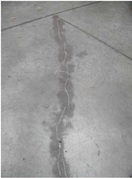
Afb. 1 Herstelling van een scheur.
