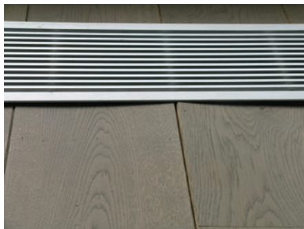
Afb. 1 Het kromtrekken (of schotelen) van de parketstroken is een vaak voorkomende pathologie.
