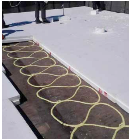
PU-schuimen worden doorgaans streeps- of slingersgewijs aangebracht.
