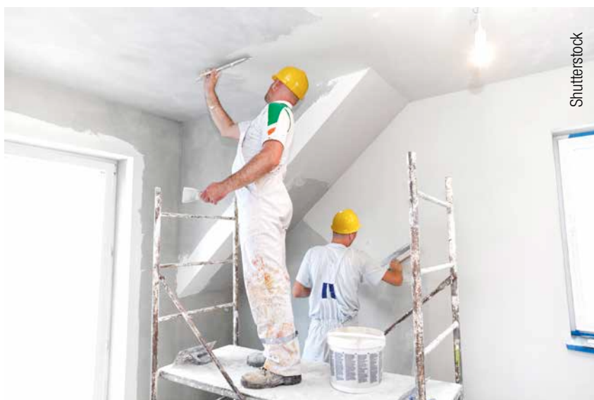
Aanbrengen van een voorbereidingsplamuur.
