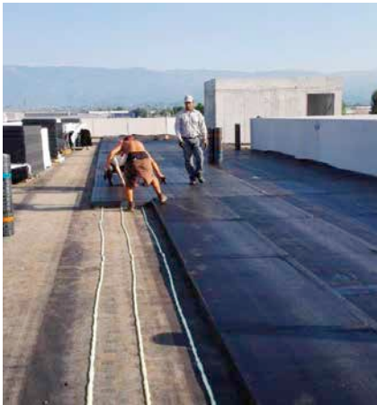
PU-schuimen worden doorgaans streeps- of slingersgewijs aangebracht.
