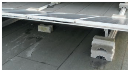
Afb. 1 Verschuiven fotovoltaïsche installatie
