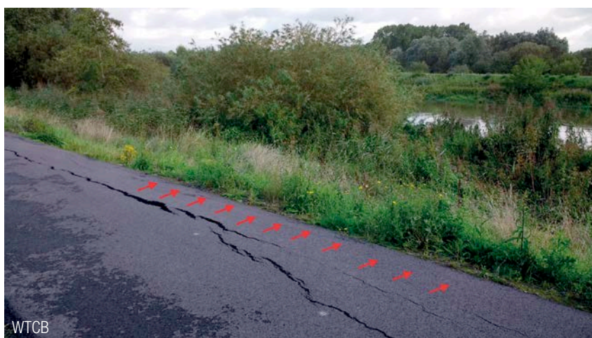
1 | Scheurvorming in een instabiele dijk langs de Schelde, in Melle.
