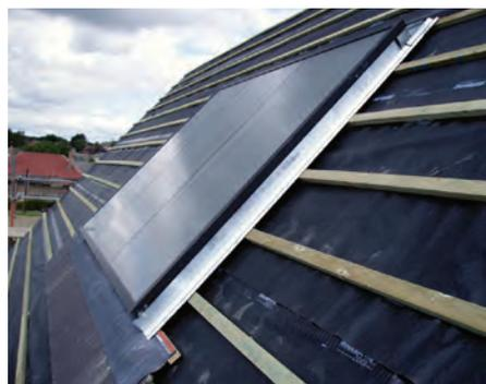
**Fig. 2** Capteurs solaires intégrés dans une toiture à versants.
