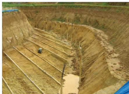
Fig. 2 Excavation des tirants d'ancrage.
