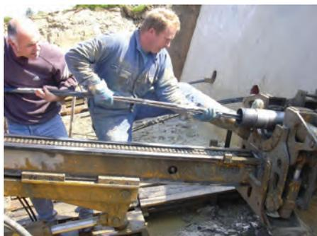
Fig. 1 Installation de tirants d'ancrage.
