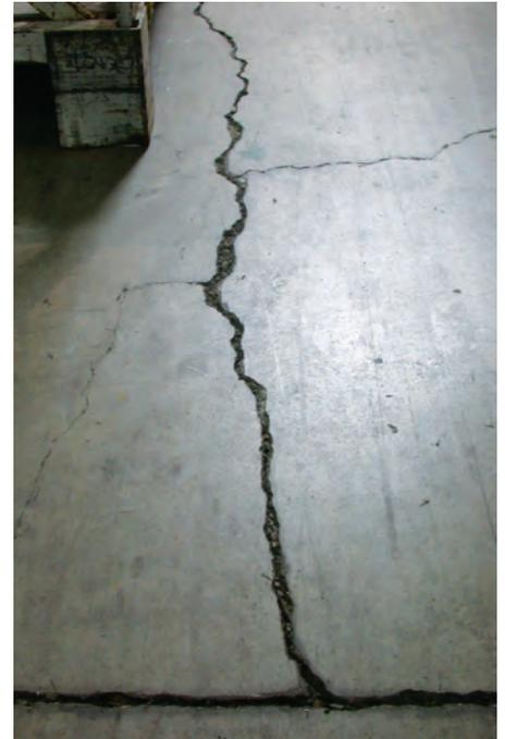
**Fissuration d'un sol industriel en béton.**
