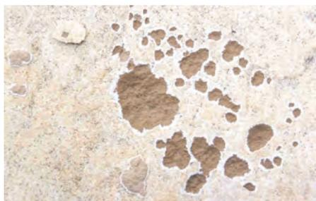
Fig. 1 Exemple d'un dégât de gel observé.
