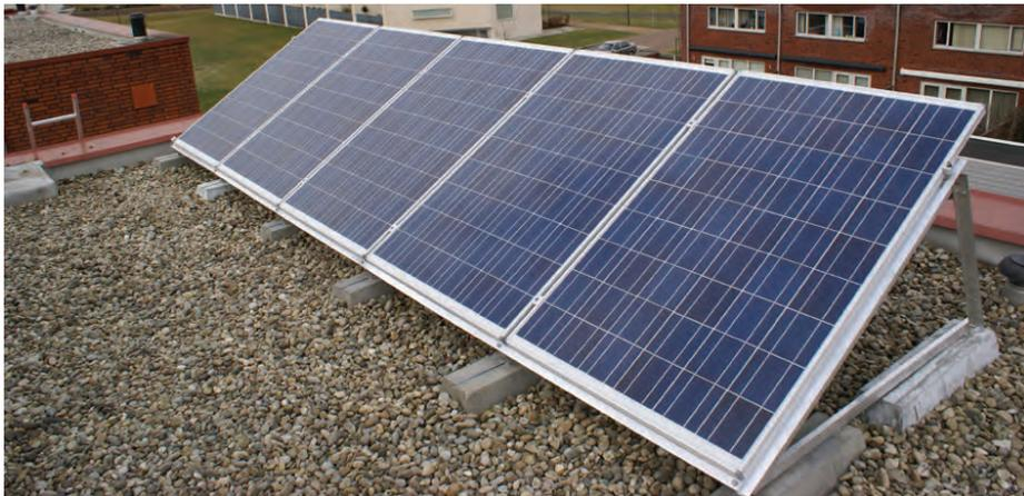
**Fig. 3 Une bonne ventilation à l'arrière des panneaux accroît le rendement de l'installation.**
