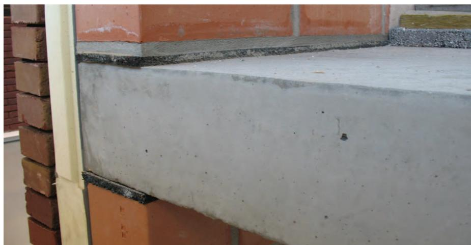
**La mise en œuvre de couches élastiques permet d'améliorer sensiblement l'isolation acoustique.**
