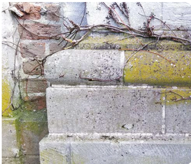
2 Façade en calcaire blanc avant et après élimination des lichens par projection de neige carbonique.
