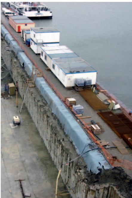
**Abb. 1** Wand vom Typ ‚Soil Mix‘ mit Boden- und Wasserschutzfunktion.
