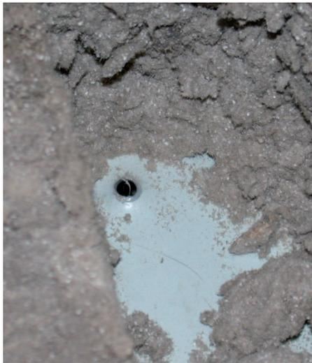
**Abb. 3 Ablösen der Schraube bei stürmischen Wetter.**
