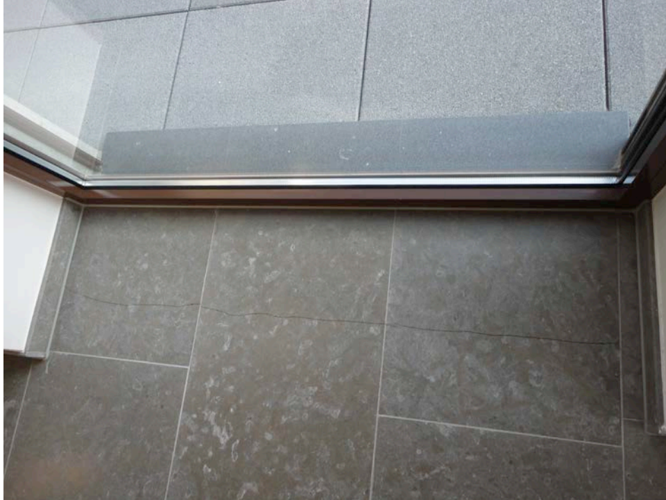
2 en 3 | Scheurvorming in een vloerbetegeling met thermische blokken onder het raam. De scheurvorming verloopt in het verlengde van de binnenzijde van de isolerende blokken
