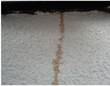
6 en 7 | Verschijning van bruinkleurige afdruipsoren door condensatievorming ter hoogte van de muurkappen
