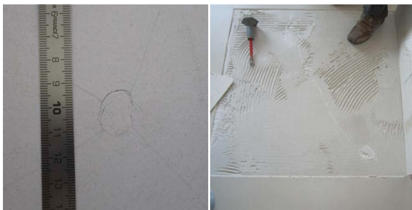
1 en 2 | Scheurvorming en ponsschade op een tegel met een zeer groot formaat en een zeer geringe dikte (links) ten gevolge van een onvoldoende verlijming (rechts)
