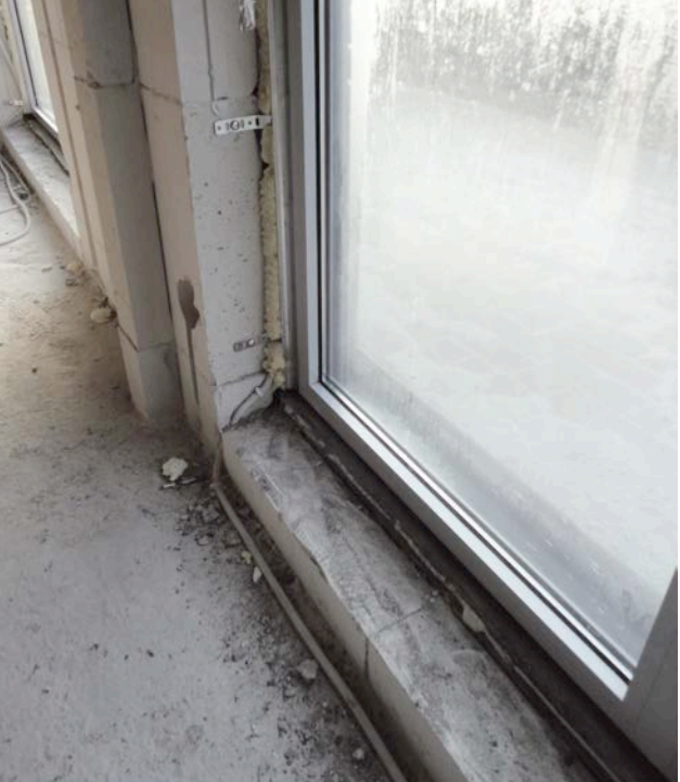
2 en 3 | Scheurvorming in een vloerbetegeling met thermische blokken onder het raam. De scheurvorming verloopt in het verlengde van de binnenzijde van de isolerende blokken
