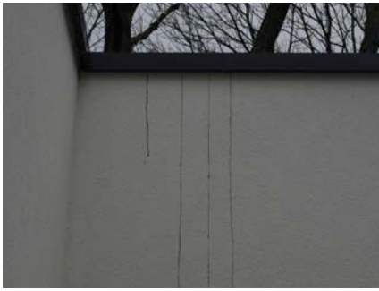
6 en 7 | Verschijning van bruinkleurige afdruipsoren door condensatievorming ter hoogte van de muurkappen
