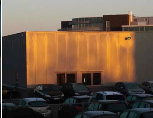
3 en 4 | Vorming van oppervlaktecondensatie in het centrale gedeelte van beglaasde vulpanelen (links) of op de elementen van een metalen gevelbekleding met geïntegreerde isolatie (rechts)
