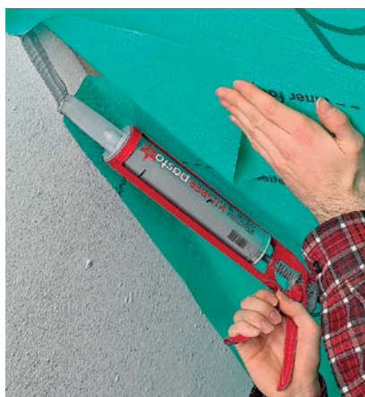
10 | Voorbeeld van een 'droog-droog'-aansluiting.
