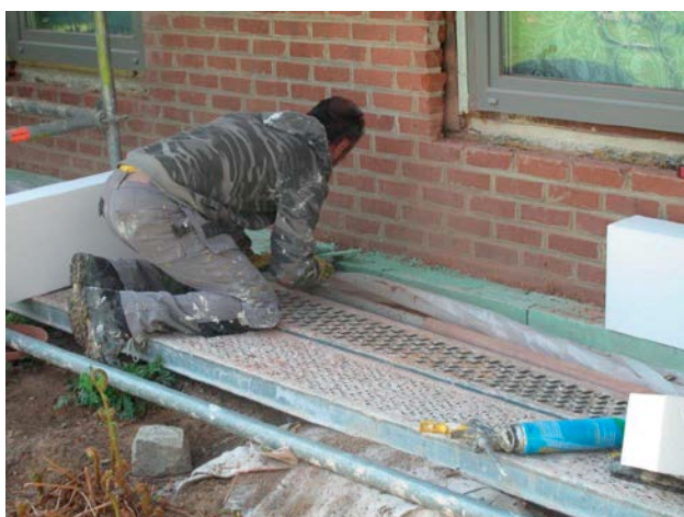
3 | Uitvoering van een gevelvoetisolatie.
