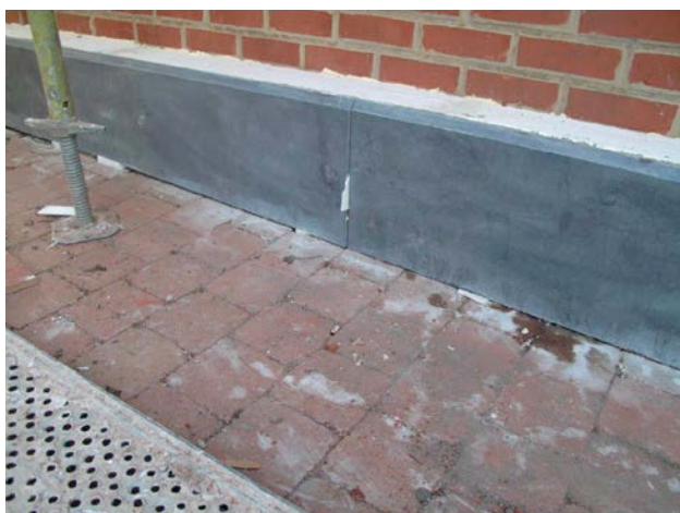
2 | Plaatsing van een ondermuur.
