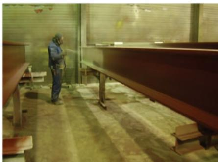
Abb. 1 Aufspritzen der Grundierung.
