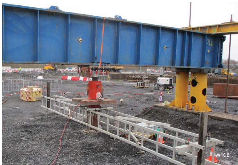
3 | Opzet van een paalbelastingsproef
