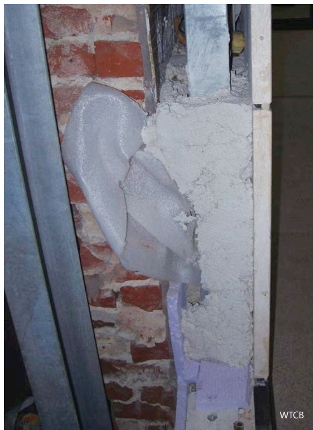
3 | Versterking van de geventileerde spouw.
