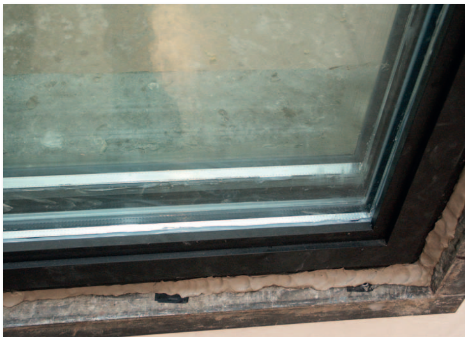
Les doubles fenêtres permettent d'atteindre des indices d'affaiblissement acoustique très élevés ( R_{Atr} > 50 dB) comparables à ceux des parties opaques de la façade
