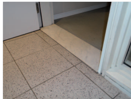
Fig. 2 Exemple de pose d'un seuil en pierre
