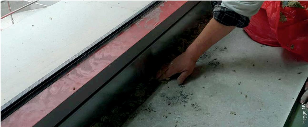
4 | Auffüllung des Zwischenraums zwischen dem flammendichten Blech und der Brandabschnittsdecke mit Steinwolle für den Erhalt einer Brandschutzabdichtung der Feuerwiderstandsklasse EI 60.
