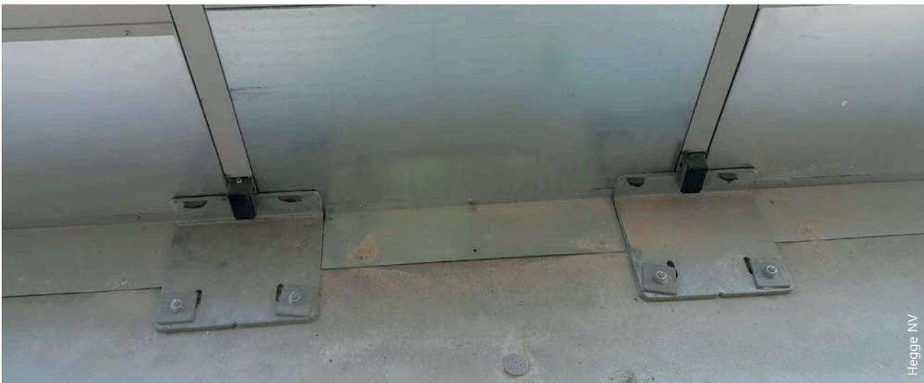
5 | Befestigung des oberen unterbrochenen und nicht verkleideten Blechs in Höhe der Verankerungen. Die horizontale Durchgängigkeit des flammendichten Bleches wird durch eine Stahlverstärkung im Aluminium-Fassadenpfosten gewährleistet.
