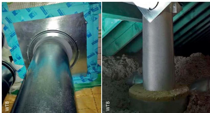
**2** | Spezifische Zubehörteile zur Gewährleistung der Durchgängigkeit der Luftdichtheit und Wärmedämmung.
