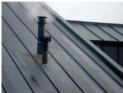
1 | Formation de taches brunes sur une toiture à proximité du conduit d'évacuation des gaz de combustion de la chaudière
