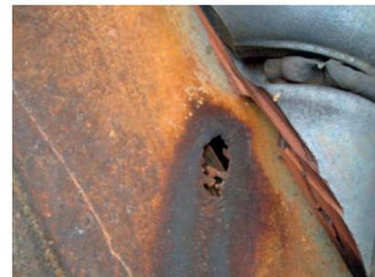
2 | Corrosion localisée due au contact direct entre les éléments métalliques de la toiture et les oxydes de fer
