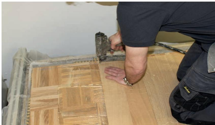
1 | Mise en œuvre d'un lamparquet de chêne sur un sous-parquet
