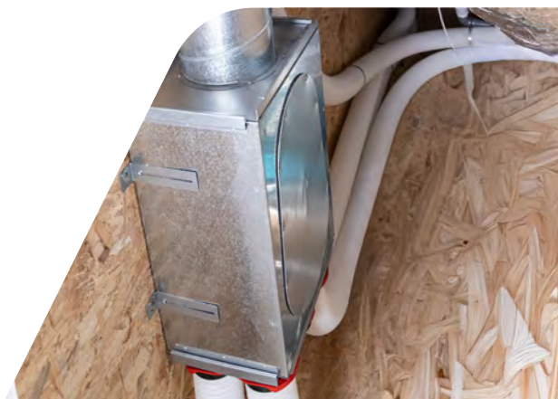
Collector met geïntegreerde geluidsdemping
