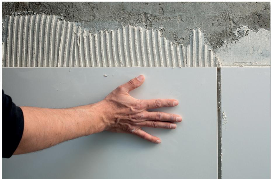
Abb. 2 Das Leimprodukt spielt eine bedeutende Rolle im Ausmaß der Spannungen.
