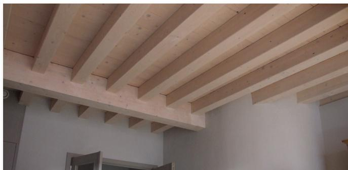
Abb. 3 Da eine Holzdecke zwischen zwei Wohnungen nicht sichtbar bleiben darf, muss eine abgehängte Decke die Schalldämmung ergänzen.
