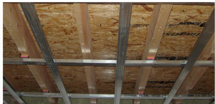
Abb. 4 Abgehängte Decke, befestigt auf einer von der Trägerstruktur unabhängigen Metallverstrebung.
