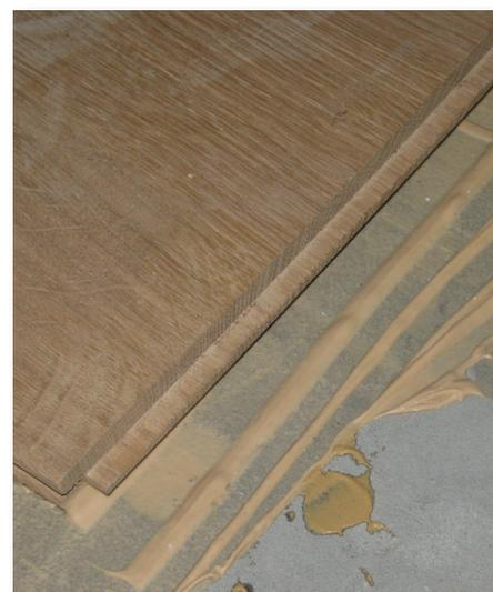
Abb. 1 Die Art des Klebers übt Einfluss auf die Trittschalldämmung von Decken aus.
