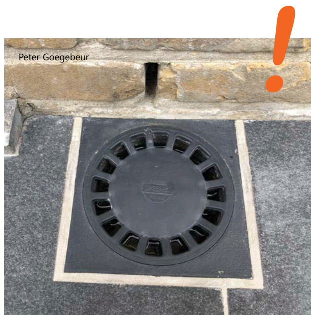
2 | Voegbeeld rondom een afvoerkolk (aanvaardbaar indien de breedte van de voeg rondom de klokput constant is en maximaal 2 mm groter of kleiner is dan de overeengekomen breedte).
