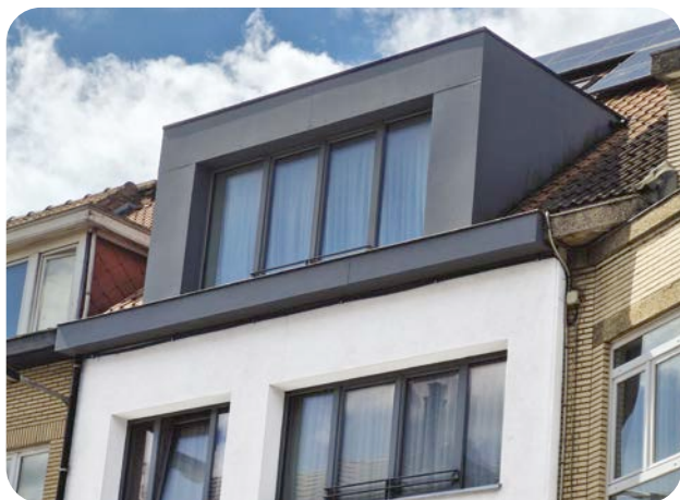
2 Uitvoering van een bakgoot.
