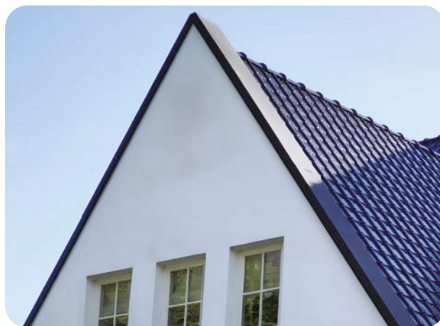
3 Isolatie van de muurkop zonder afslijping.
