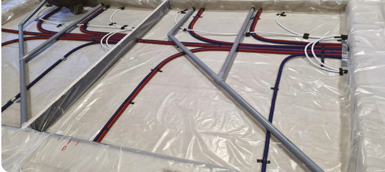
2 Twee proefopstellingen met identiek leidingenpatroon, vóór het aanbrengen van de uitvullaag.
