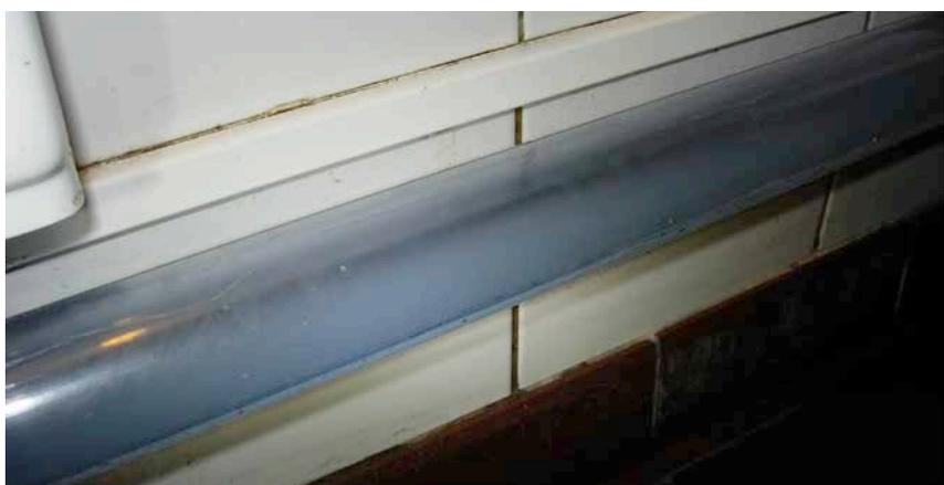
Veranschaulichung der Wirkung eines geeigneten Pflegemittels auf die Ablagerung von Urin in der transparenten Abflussleitung von einer Reihe wasserloser Urinale im Bahnhof Brüssel-Nord, und zwar vor, während und nach der Anwendung des Pflegemittels.
