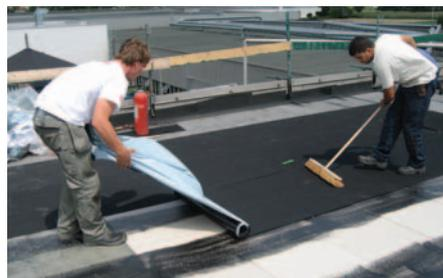
**Fig. 2 Application des bandes avec joint longitudinal sur la nervure supérieure.**
