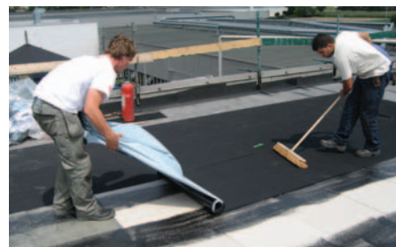
Afb. 1 Uitvoering van een zelfklevend membraan.
