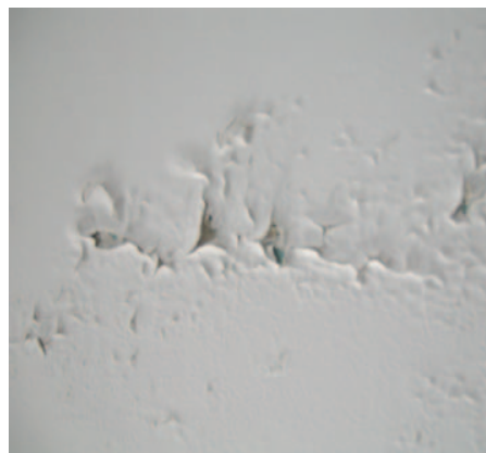
Afb. 1 Veroudering van een verf op basis van vinylhars.
