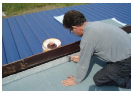
Afb. 4 Uitvoering van de dakopstand.
