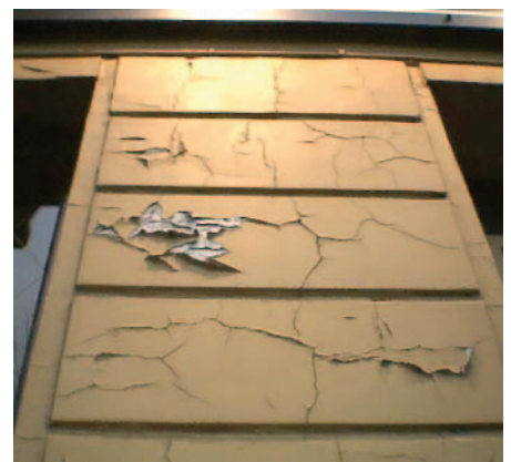
Afb. 2 Veroudering van een verf op basis van alkydhars.
