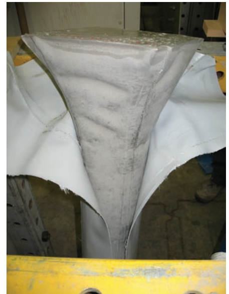
Abb. 2 Querschnittsanpassung innerhalb ein und derselben Säule.
