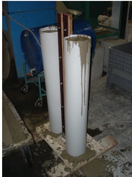
Abb. 1 Ausführung von geraden runden Säulen mit einer Textilschalung.
