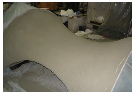
Abb. 3 Ausführung einer doppelgekrümmten Schalstruktur mit Spritzbeton.
