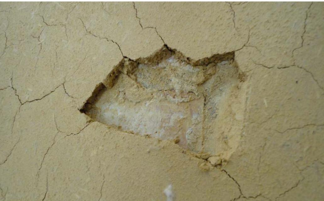
der Innenputz in einem Raum mit einem sehr trockenen Raumklima angebracht (es waren vor Beginn der Putzarbeiten während einer längeren Zeit Luftentfeuchter im Raum vorhanden). Dies hat wahrscheinlich zu einer schnelleren Trocknung des Innenputzes geführt, was das Entstehen von Schwindungsrissen zur Folge hatte.
