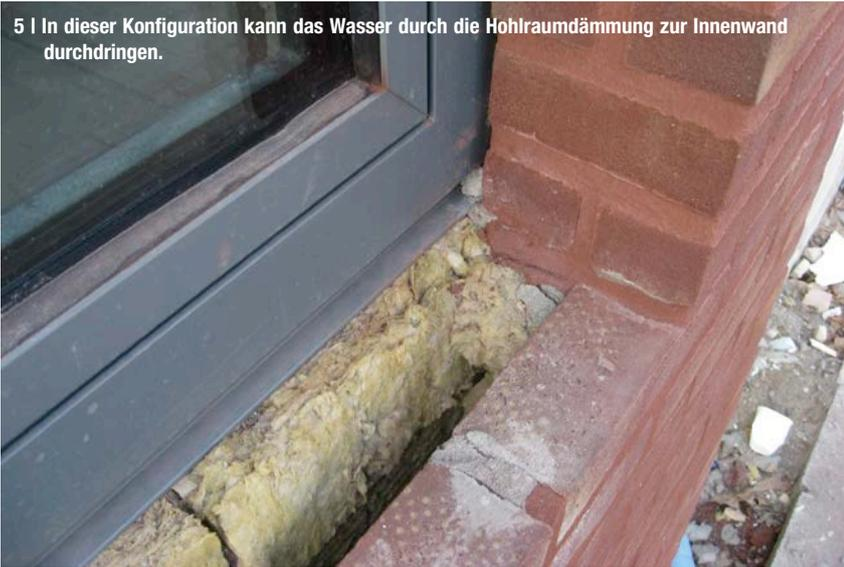
dichte Membran an, die das Wasser am Rücksprung auffängt (siehe Abbildung 4).
