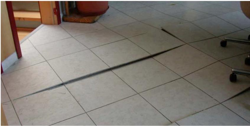
3 | Wölbung des Fliesenbelags auf einem gehärtetem Estrich.
