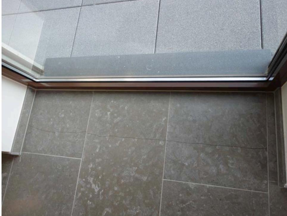
2 und 3 | Rissbildung in einer Bodenverfliesung mit gedämmten Blöcken unter dem Fenster. Der Riss verläuft in der Verlängerung der Innenseite der Blöcke.
