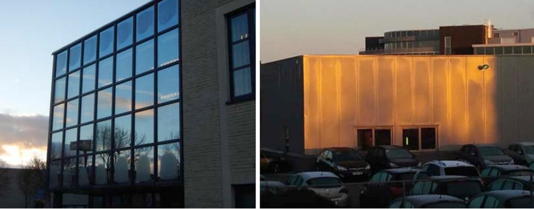
3 und 4 | Bildung von Oberflächenkondensation im mittigen Teil von verglasten Füllpaneelen (links) oder auf den Elementen einer Fassadenverkleidung aus Metall mit integrierter Dämmung (rechts).
