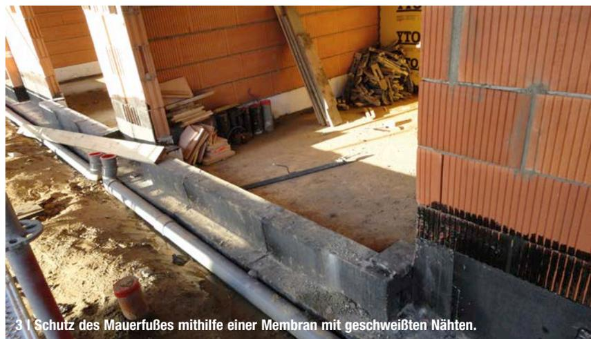
**3 | Schutz des Mauerfußes mithilfe einer Membran mit geschweißten Nähten.**
