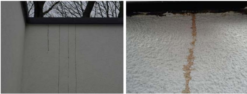
6 und 7 | Erscheinung von bräunlichen Abtropfspuren durch Kondensationsbildung in Höhe der Mauerabdeckungen.
