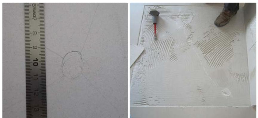
1 und 2 | Rissbildung und Eindringsschaden an einer Fliese mit einem sehr großen Format und einer sehr geringen Dicke (links) als Folge einer unzureichenden Verklebung (rechts).
