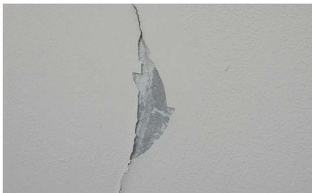
1 | Détérioration d'un revêtement alkyde sur un support en béton non carbonaté et en présence d'humidité.
