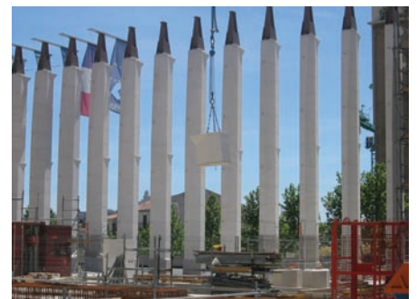
Nachgespannte Säulen im Bahnhof „Saint-Charles“ in Marseille.
