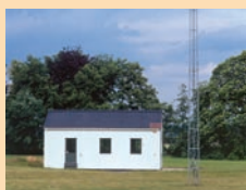
Limelette: Errichtung des ‚Wind‘- Gebäudes
