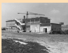
Limelette: Errichtung der ersten Versuchsgebäude
