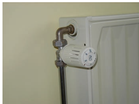
Das Thermostatventil: eine einfache Lösung für die Innentemperaturregelung in jedem Raum.
