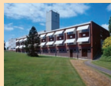
Limelette: Renovierung und energetisches Moni- toring des ‚Probe‘- Gebäudes
