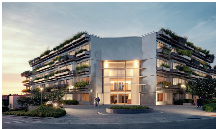
Via een seasonal commissioning contract volgen Boydens Engineering en SECO de metingen en installaties het eerste jaar grondig op.
