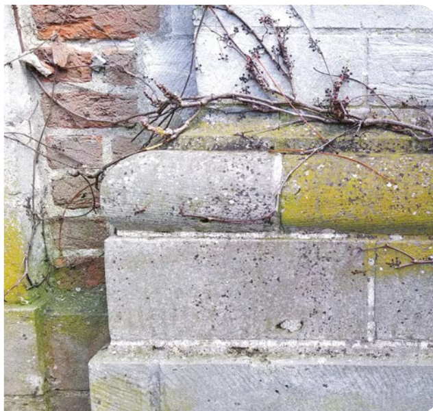
2 Gevel uit witte kalksteen vóór en na de reiniging van korstmoss door droogijssstralen.
