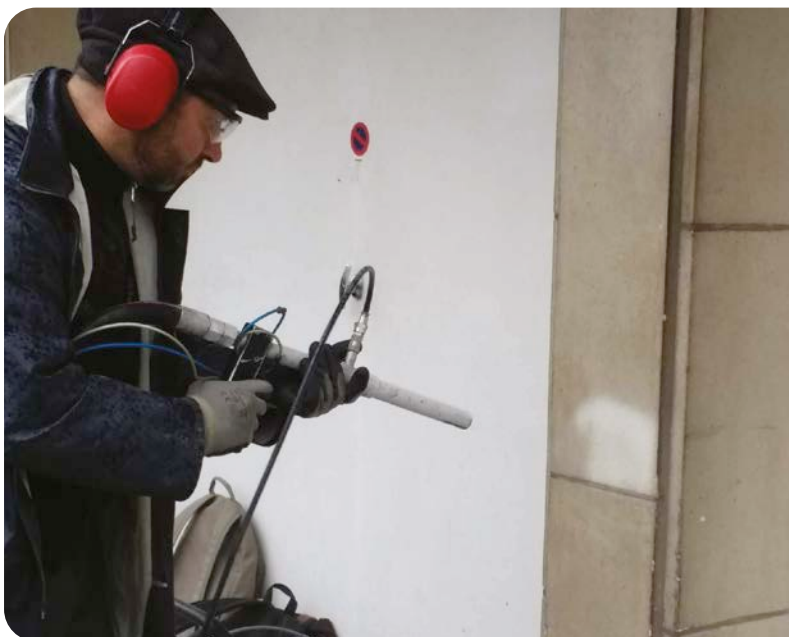
1 Gevelreiniging met droogijsstralen en een kleine toevoeging van klassiek straalmiddel.
