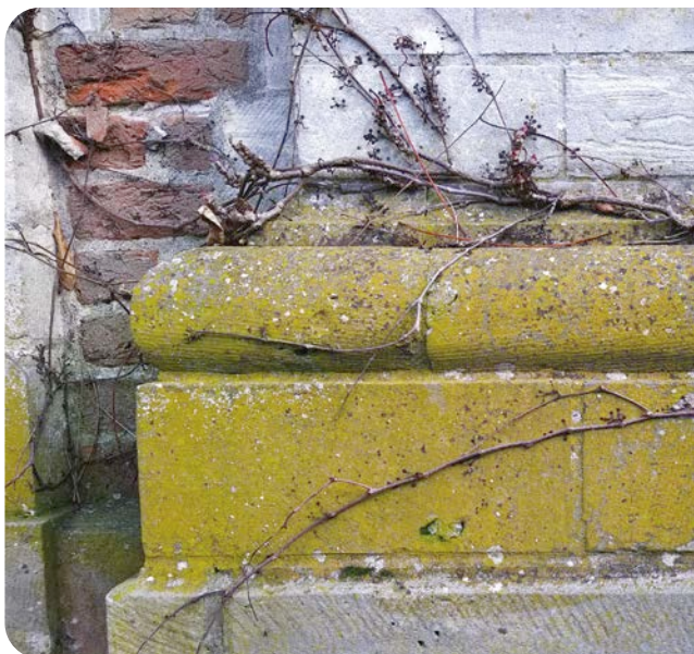
2 Gevel uit witte kalksteen vóór en na de reiniging van korstmoss door droogijssstralen.
