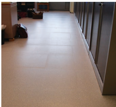
Fig. 1 Revêtement de sol souple au travers duquel on distingue encore le support.
