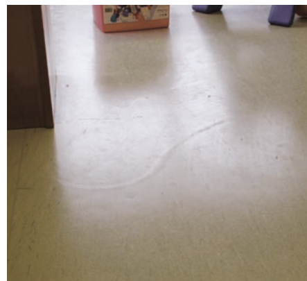
Fig. 1 Revêtement de sol souple au travers duquel on distingue encore le support.
