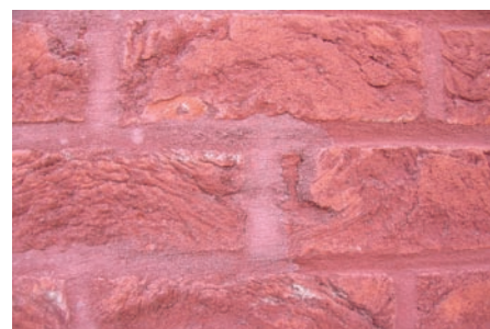
Fig. 3 Variations de teinte sur les joints.
