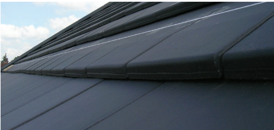
Fig. 3 Mesure de la flèche d'une couverture.
