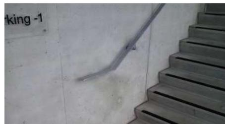
**FIGURE 61 : ESCALIER EN BÉTON TRADITIONNEL AVEC NEZ DE MARCHE NOIRS**
