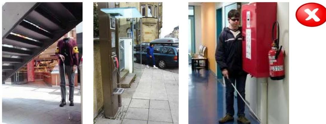
FIGURE 51 : QUELQUES MAUVAIS EXEMPLES : (1) L'ESPACE SOUS L'ESCALIER N'EST PAS PROTÉGÉ (2) LA PAROI VITRÉE DE LA CABINE TÉLÉPHONIQUE EST DIFFICILEMENT REPÉRABLE, MÊME POUR UNE PERSONNE NE SOUFFRANT PAS DE PROBLÈMES DE VUE (3) LE DÉVIDOIR D'INCENDIE CONSTITUE UN OBSTACLE
