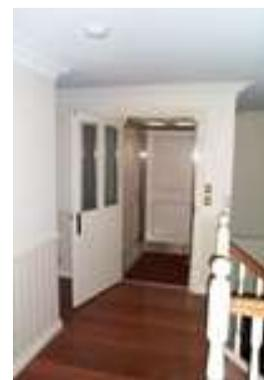
FIGURE 36 : PLANCHER D'ASCENSEUR DE LA MÊME COULEUR QUE LE PALIER DE L'ASCENSEUR ET EN CONTRASTE AVEC LES MURS
