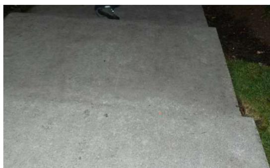
**FIGURE 44 : DIFFÉRENCE DE NIVEAU À UN ENDROIT INATTENDU**
