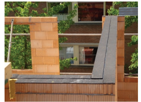
Afb. 2 De elastische stroken (in het zwart) zorgen ervoor dat de betonnen vloerplaten akoestisch ontkoppeld worden van de rest van de constructie.
