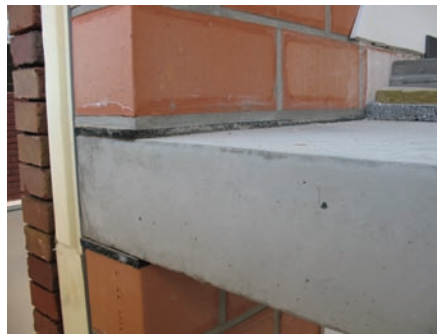
Afb. 2 De elastische stroken (in het zwart) zorgen ervoor dat de betonnen vloerplaten akoestisch ontkoppeld worden van de rest van de constructie.
