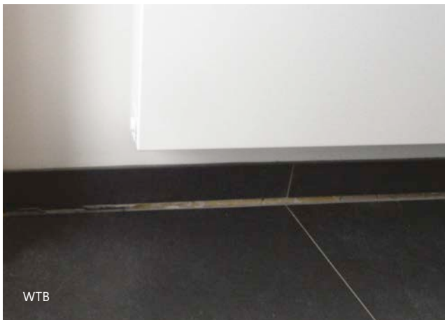
2 und 3 | Diverse Schadenfälle, die aufgrund einer Setzung des gespritzten Polyurethanschaums festgestellt wurden.
