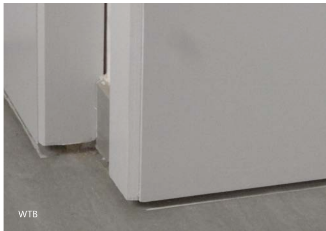
2 und 3 | Diverse Schadenfälle, die aufgrund einer Setzung des gespritzten Polyurethanschaums festgestellt wurden.
