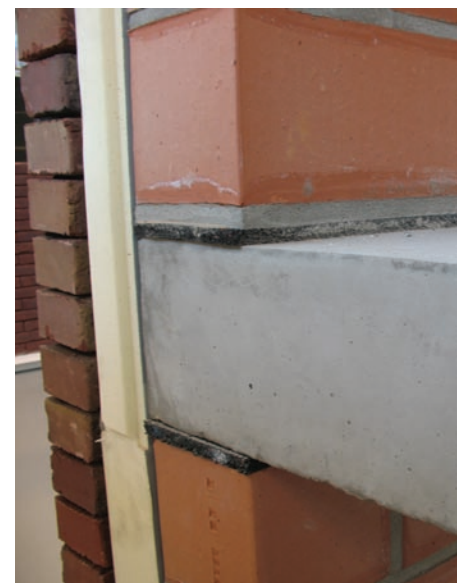
Innovatief bouwdetail met een elastische voeg (verbeterde geluidsisolatie).
