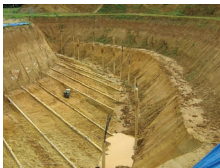
Testen van grondankers op reële schaal.
