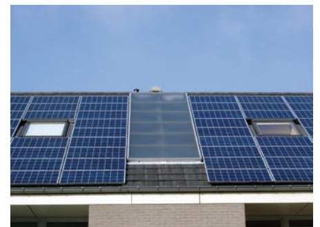
Integratie van zonne-energie-technologie in een dak.
