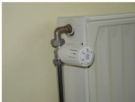
Thermostaatkranen : een eenvoudige oplossing voor de warmteregeling in elke ruimte.
