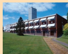
Limelette : renovatie en energetische monitoring van het 'Probe'-gebouw
