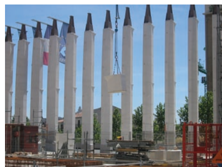
Nagespannen kolommen in het station 'Saint-Charles' te Marseille.
