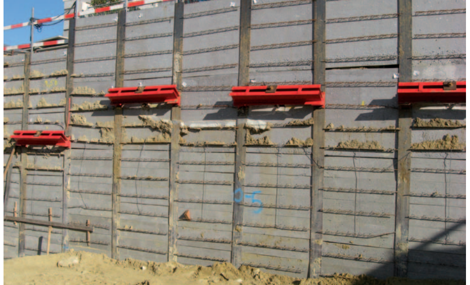
Beispiel eines Berliner Verbaus. ▲
