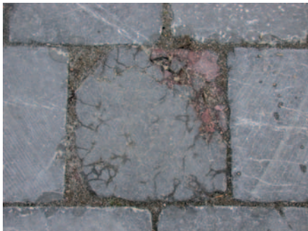
Abb. 1 Durch Metamorphosen und Trommeln versprödetes Pflaster.
