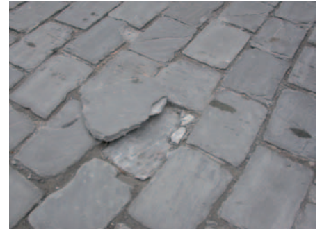
Abb. 3 Abspaltungen bei exotischen Pflastern.
