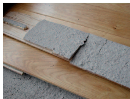
Ausbruchstellen an der Oberseite des Estrichs infolge durch Feuchtigkeit verursachter Bewegungen des Holzes.
