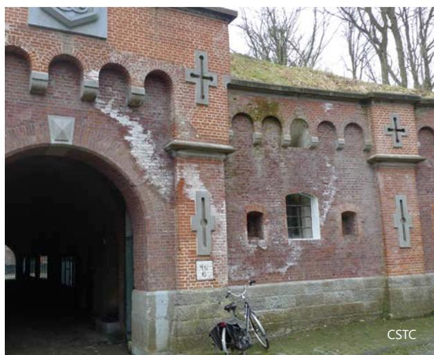
1 | Efflorescences de sels apparues lors du séchage d'un mur à la suite d'infiltrations.
