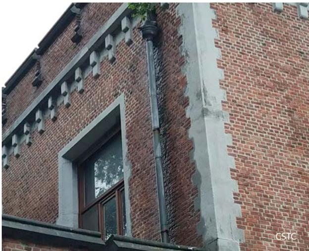
3 | Infiltrations dues à un mauvais entretien de la descente d'eau.
