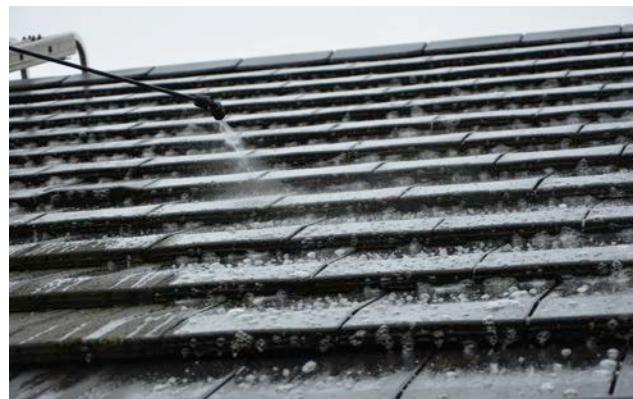
3 | Mise en œuvre par nébulisation d'un produit à base d'enzymes
