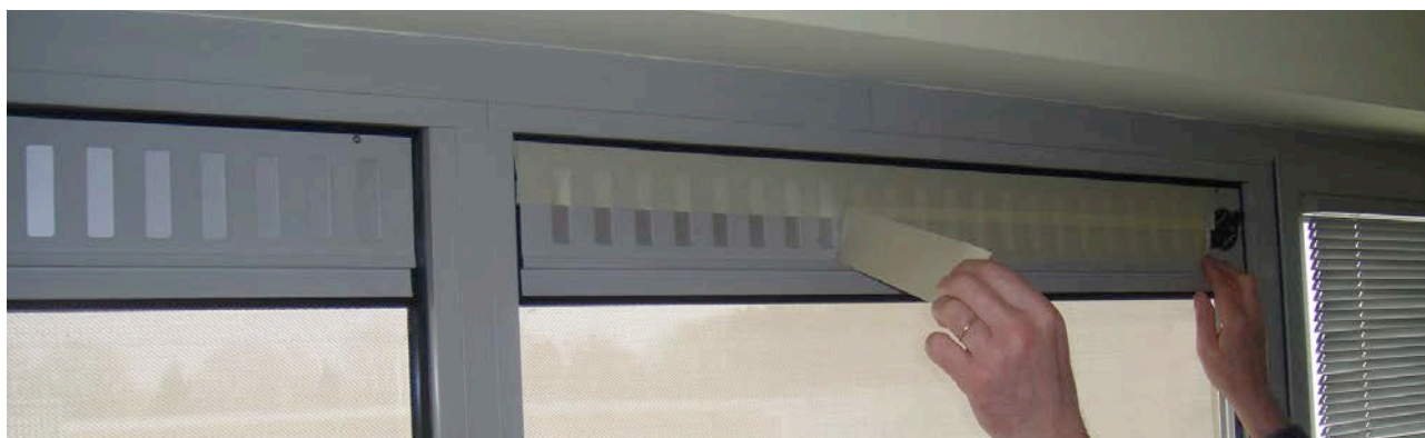
Scellement d'une ouverture de ventilation au moyen d'une bande adhésive
