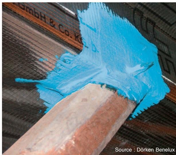
Fig. 2 Application d'un produit liquide d'étanchéité à l'air
