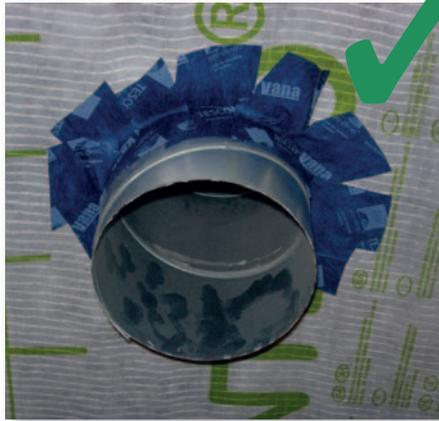
**Fig. 7** Pose radiale des bandes adhésives (solution satisfaisante)
