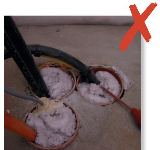
**Fig. 5 Fourreaux inadaptés au diamètre des conduites**
