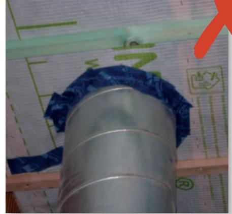
**Fig. 8** Pose tangentielle des bandes adhésives (à déconseiller)
