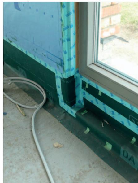
Fig. 2 Raccord entre une paroi à ossature en bois et une dalle de béton au moyen d'une membrane synthétique
