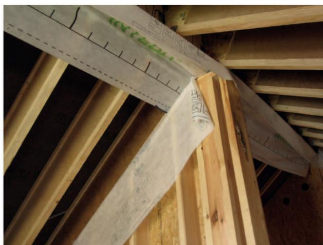
Fig. 6 Raccord entre une cloison et une faîtière. La continuité de la barrière d'étanchéité à l'air est assurée par une membrane d'attente.
