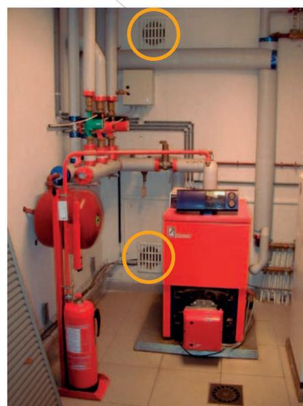
Fig. 1 Ventilation du local d'installation
