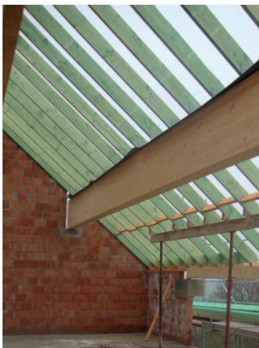
Fig. 5 Détail nécessitant une coordination adaptée : les lés sont placés sur les pannes avant la suite du montage de la charpente; ils seront ensuite joints au pare-vapeur afin d'assurer la continuité de l'écran à l'air sur tout le versant de toiture.
