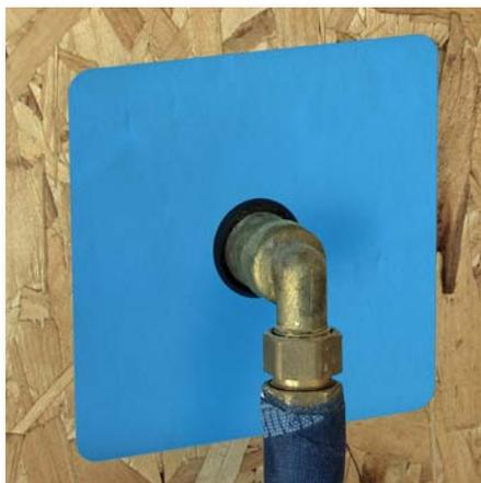
**Fig. 4 Manchon collé sur le panneau OSB intérieur**
