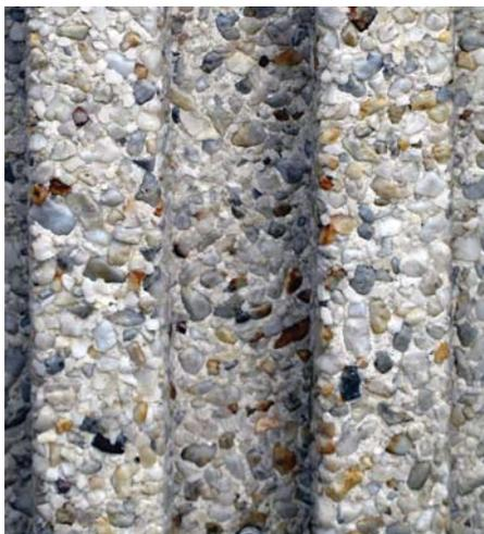
**Abb. 1** Normales Aussehen: die dunkleren Granulate sind sichtbar.
