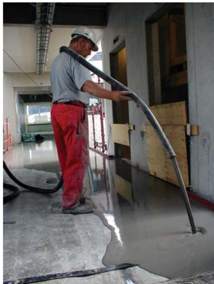
**Verlegung eines selbst verdichtenden Gußestrichs.**
