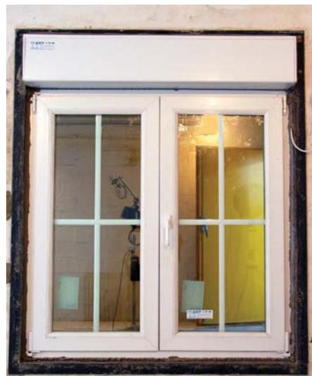
**Abb. 2** Um eine gute Isolierung zu erzielen ist es nötig auch den Rolladenkasten selbst zu behandeln.
