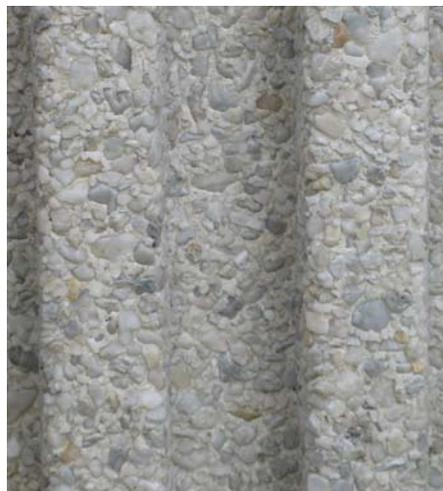
**Abb. 2** Hellere Fassadenfläche: die dunkleren Granulate sind von weißen Salzen bedeckt.
