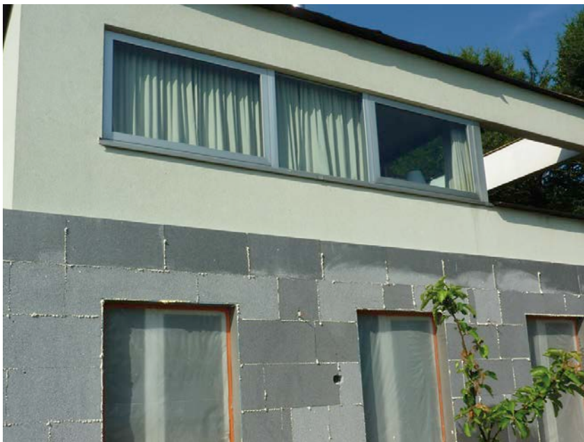
1 | Energetische renovatie door op het reeds bestaande ETICS een bijkomend ETICS aan te brengen.
