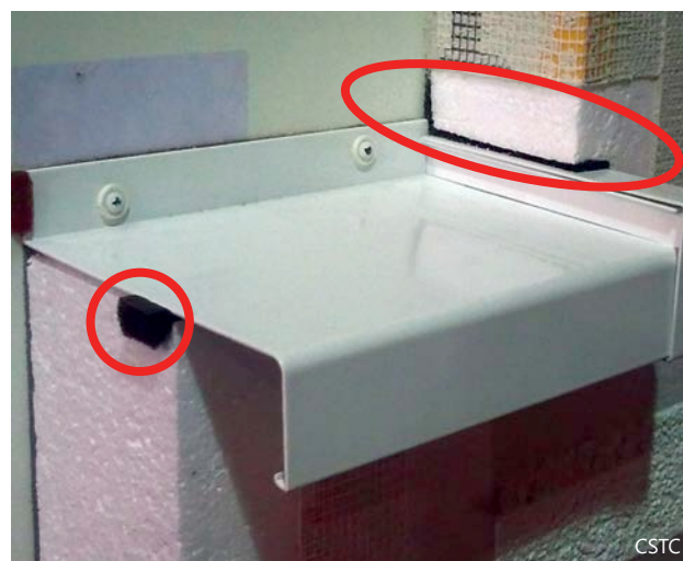
1 | Etanchéification d'un seuil au moyen de bandes précomprimées.
