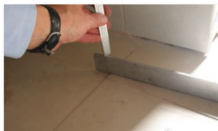
Afb. 1 Opmeting van het reële niveauverschil tussen twee aangrenzende tegels
